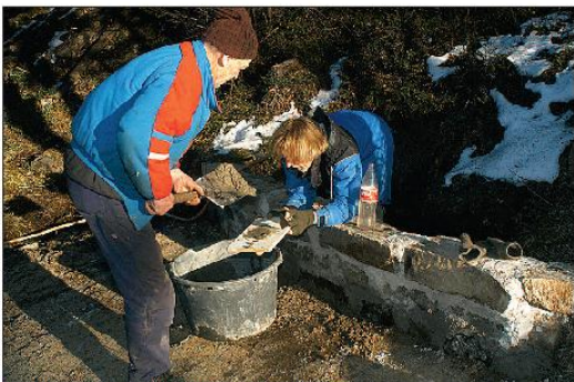
Arne Marius Sletum og Eivind Peder Hveem murer så fort de kan. Tilslaget av vann er stort, og med jevne mellomrom må de tappe oppkommet med hevert for at den ferske sementen ikke skal bli våd.
