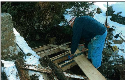
Kristian Ødegård søker nytt dekke over selve Olavskilden, oppkommet som benyttes til drikkevann for folk. Kilden var dekket med belteblikk, noe Olavskildens venner mente var helt feil. Steinen til venstre skal også bli tilbake den gamle inskripsjonen.
