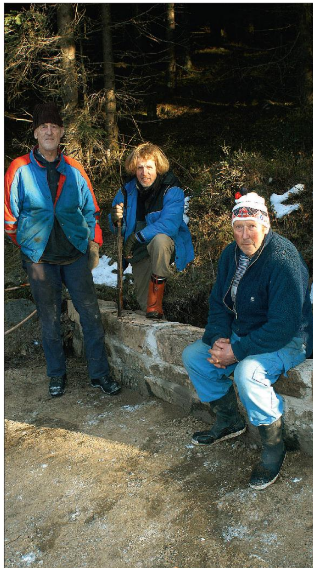
Olavskildens arbeidslag, bestående av entusiastene, bygger opp igjen den gamle hestevatinninga på vegen mellom Skjeppejvnen og Torsætra på Totenåsen. Fra venstre Arne Marius Sletum, Eivind Peder Hveem og Kristian Ødegård.
