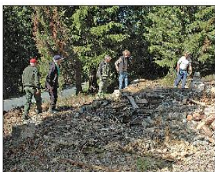
Arbeidsgjengen som var med og demonterte Tåmåsstuga ser over tomtegrunnet den gamle huset hadde stått på.
