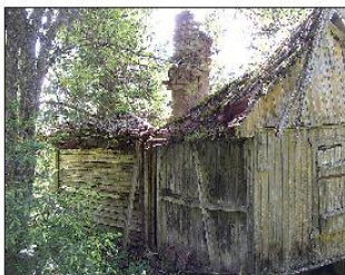
Slik så Tåmåsstuga ut før de begynte å demontere den i fjor høst. (Foto: Reidar Brennsæter).
